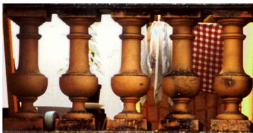
Balustres rondes tournées à la corde ou sur le tour.
