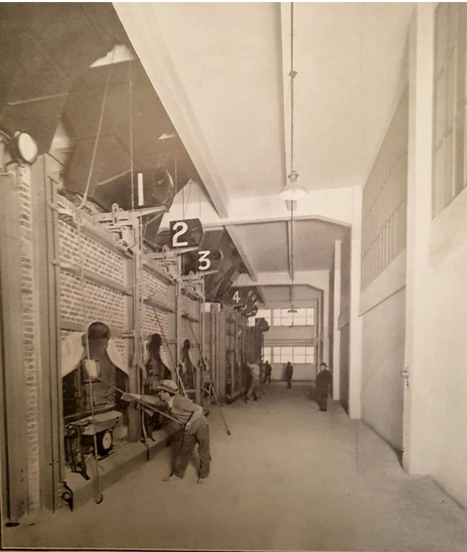
FIG. 4. — Vue de la Galerie des Fours.
