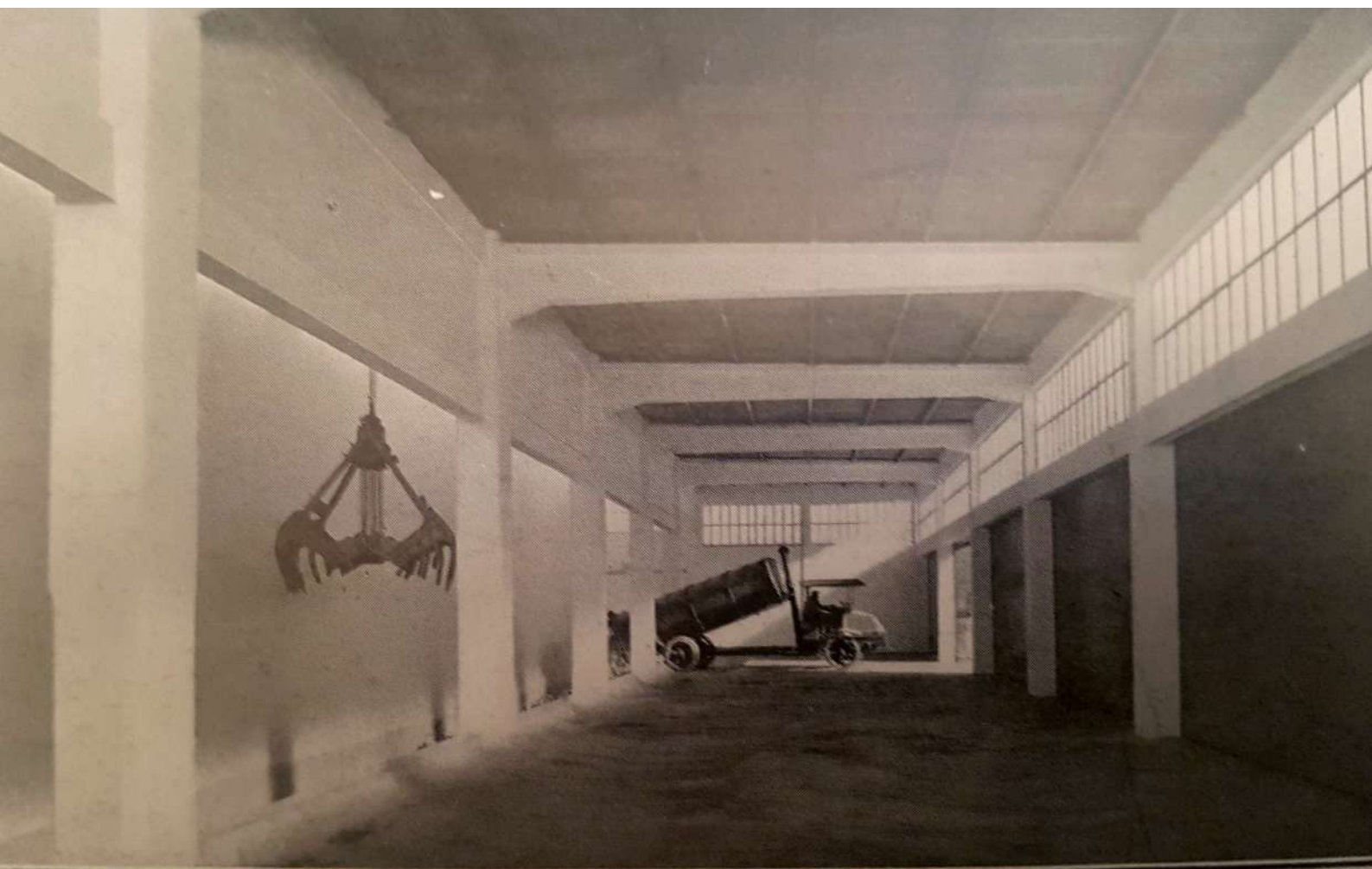
FIG. 2. — Salle de déversement des ordures.
