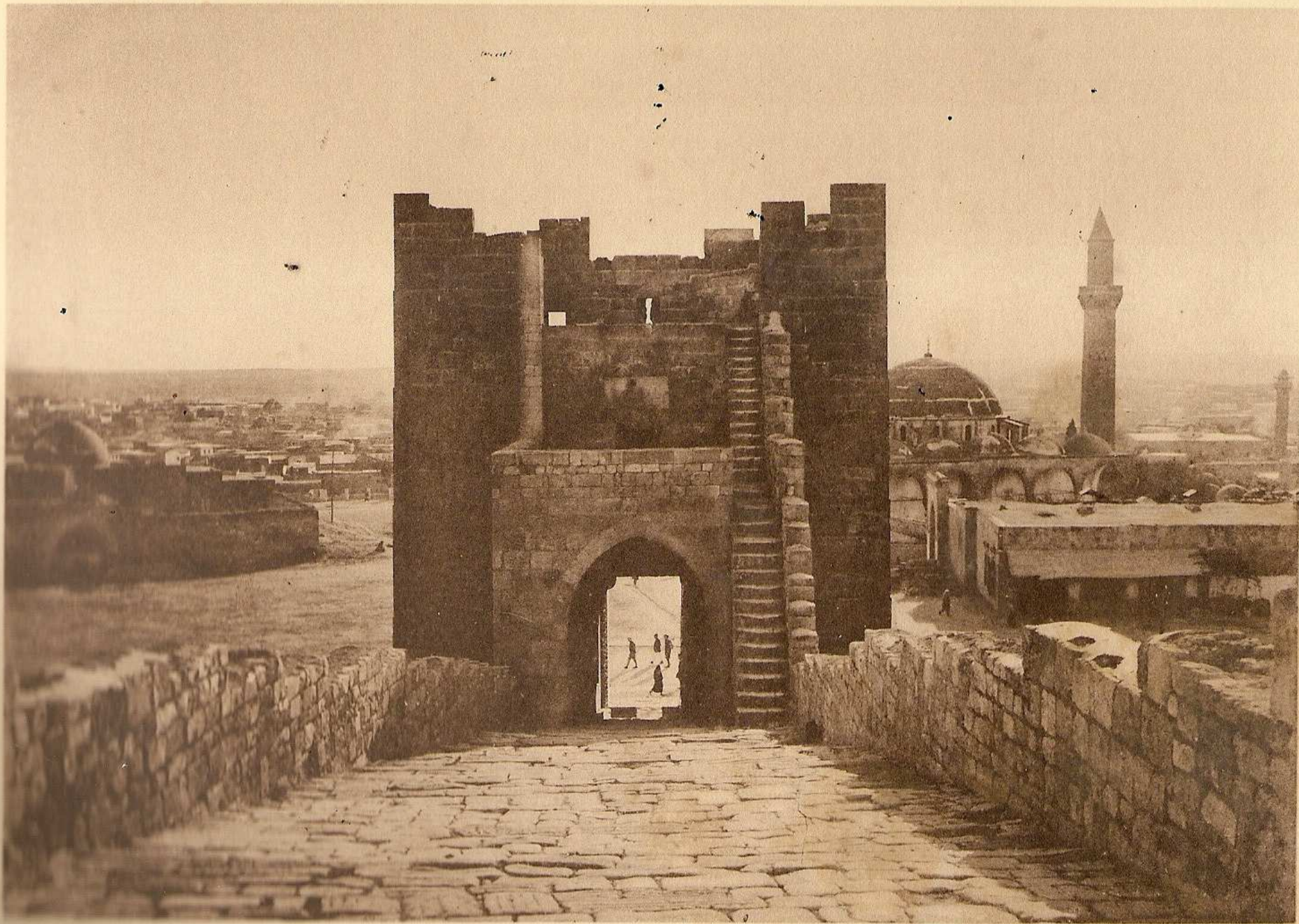
La première défense à l'entrée de la Citadelle vue de l'Intérieur (XIII e et XV e S.)
