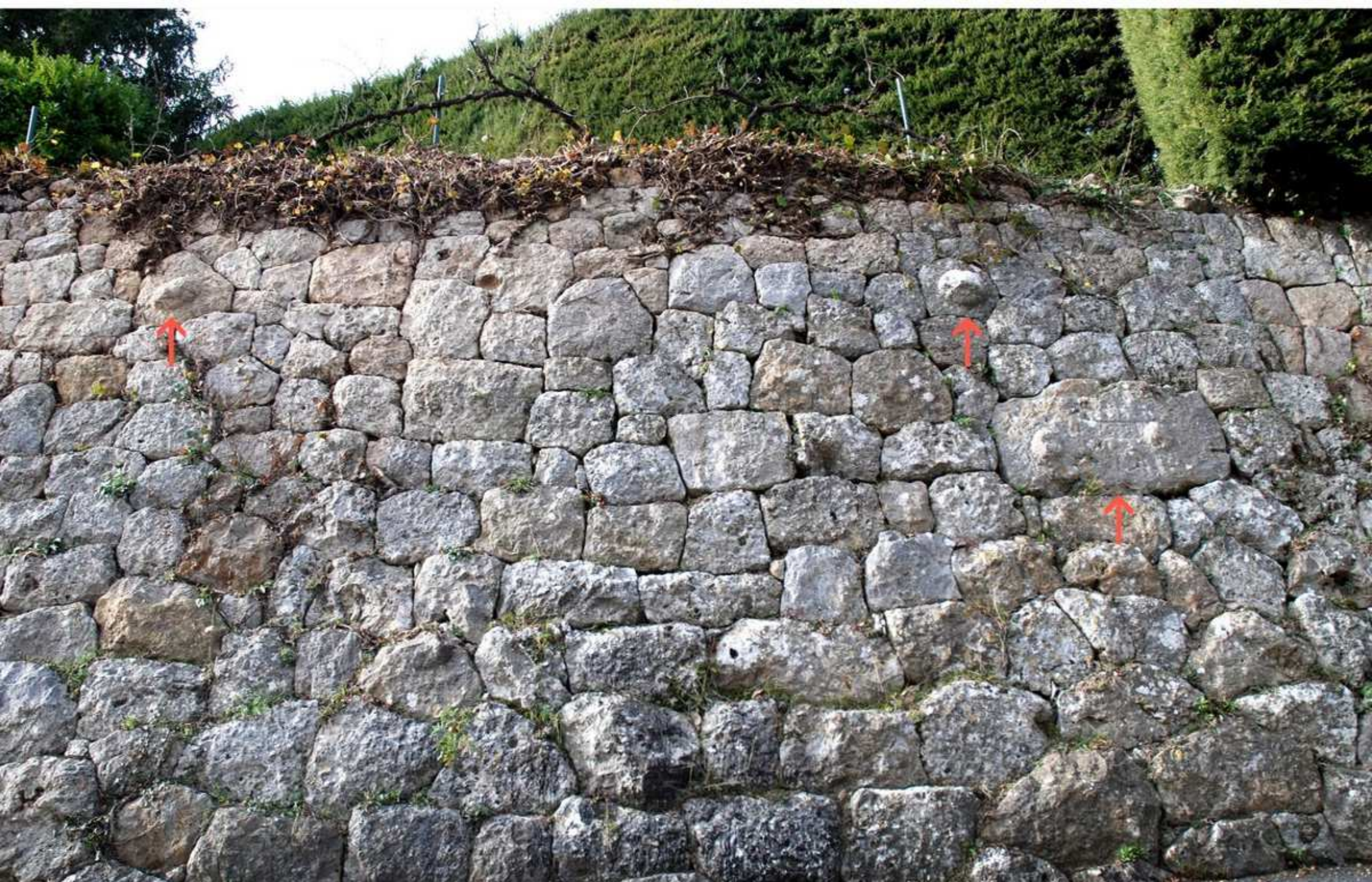
Route Jean Natale Carros Mur de soutènement à joints vifs, pierres à bossages et bloc millésimé 1869 dans cartouche en creux.
